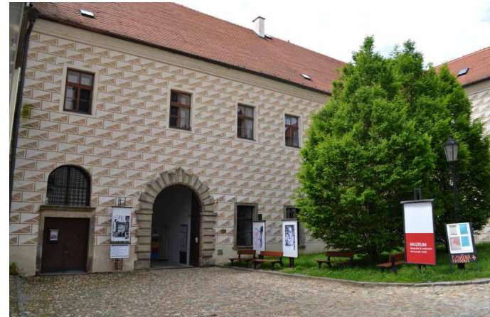
► Ve zrekonstruované jezuitské koleji dnes sídlí muzeum fotografie. (Zdroj: Město Jindřichův Hradec, www.jh.cz )
