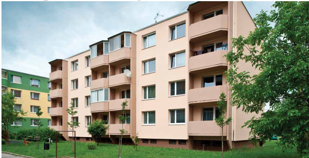
Rekonstruovaný bytový dům v Kroměříži.
